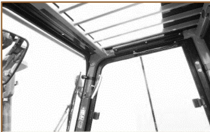
Vue intérieure du toit après montage
