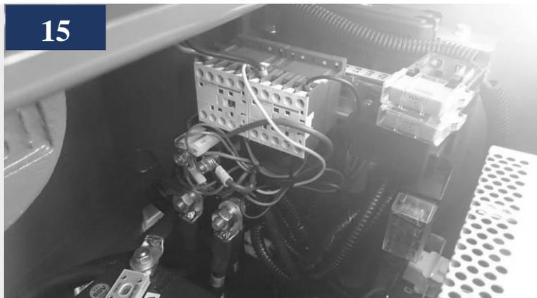
INSTALLER LE CONTACTEUR ET LES FUSIBLES FOURNI SUR LA TOLE ARRIERE DU COFFRE A BATTERIE.
